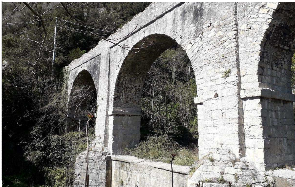
Ponte Canale sul torrente Geirato
