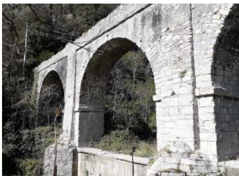
Ponte Canale sul Torrente Geirato
