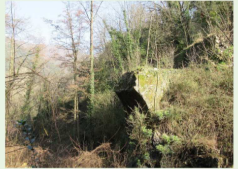
Resti del Ponte Ronco
