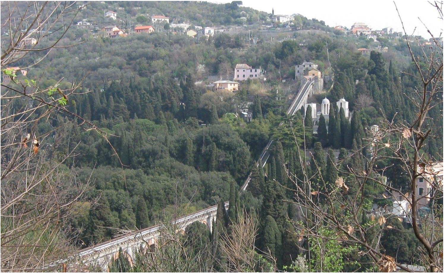
66 Ponte sifone sul Veilino
