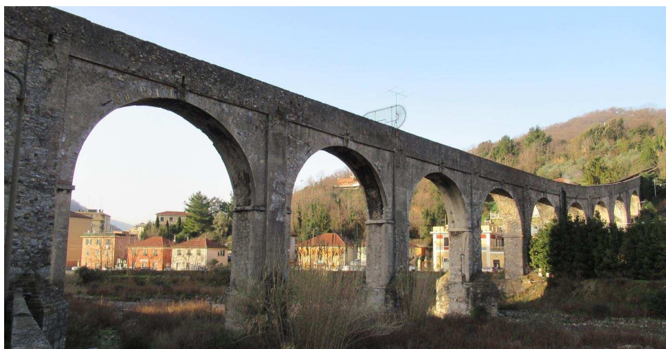
Ponte Sifone sul torrente Geirato
