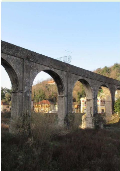
Ponte Sifone sul Torrente Geirato
