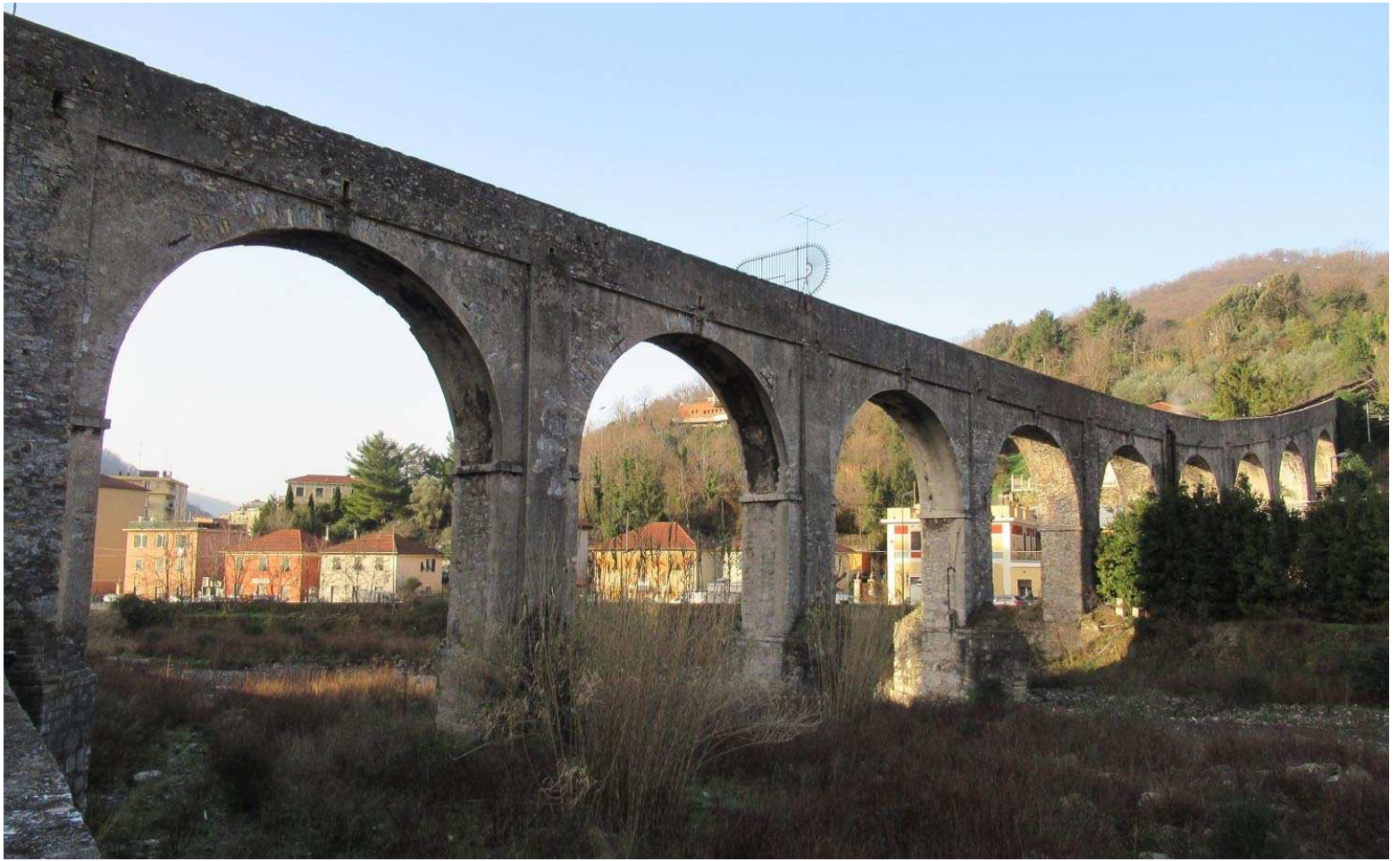
48 Ponte Sifone sul Torrente Geirato
