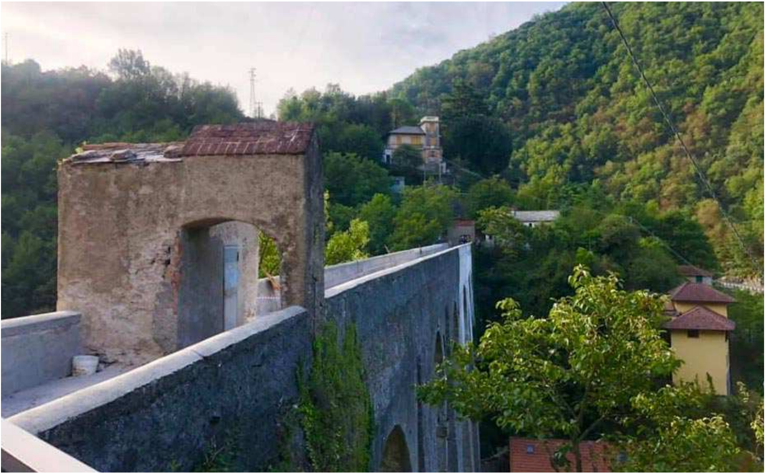
Porte per accedere al Ponte di Cavassolo
