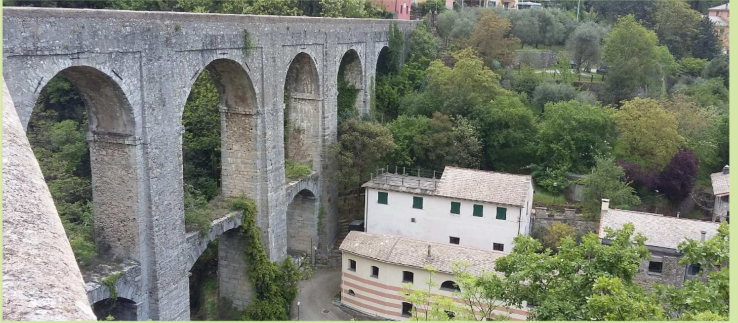
46 Ponte sul Rio Torbido
