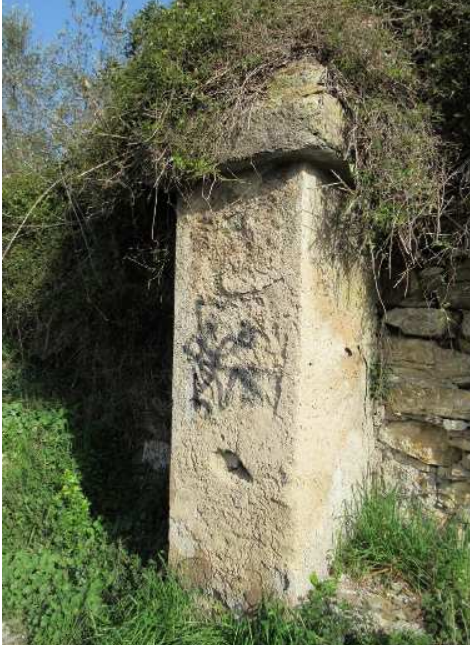
Pompa per aspirazione acqua
