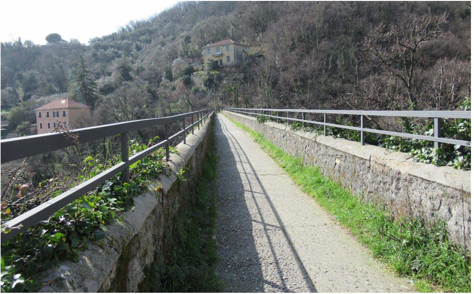
54 Ponte di Preli
